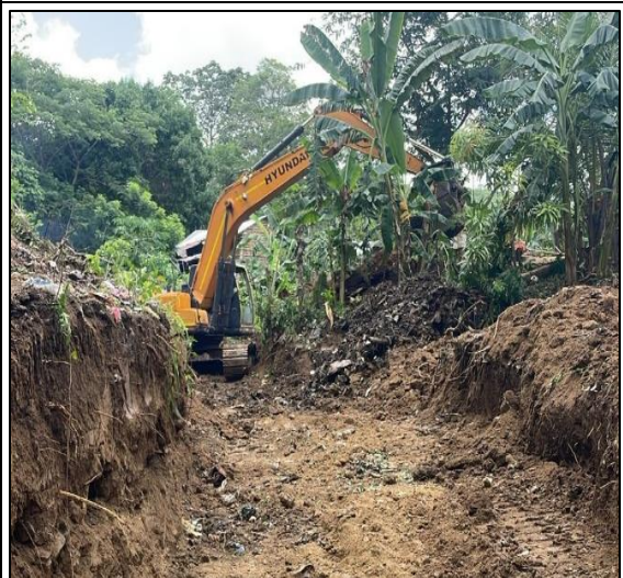
ÍTEM No. 4: EXCAVACIONES VARIAS SIN CLASIFICAR
