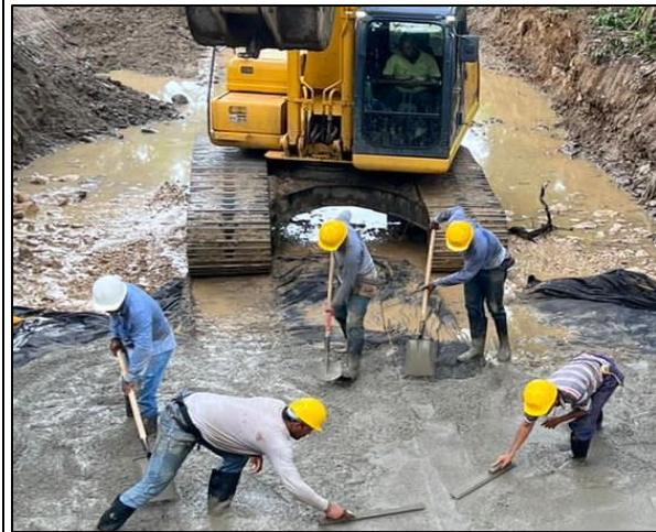
ÍTEM No. 8: CONCRETO DE RESISTENCIA 14 Mpa (TIPO F) (PARA SOLADO Y E = 5 CM)
