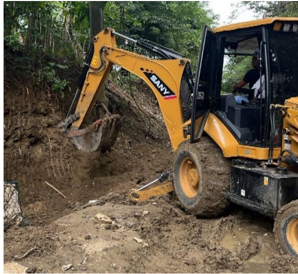
ÍTEM No. 14: EXCAVACIONES VARIAS SIN CLASIFICAR
