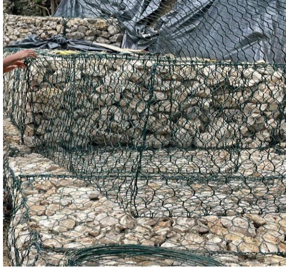
ÍTEM No. 13: EMPEDRADO PARA TALUDES
