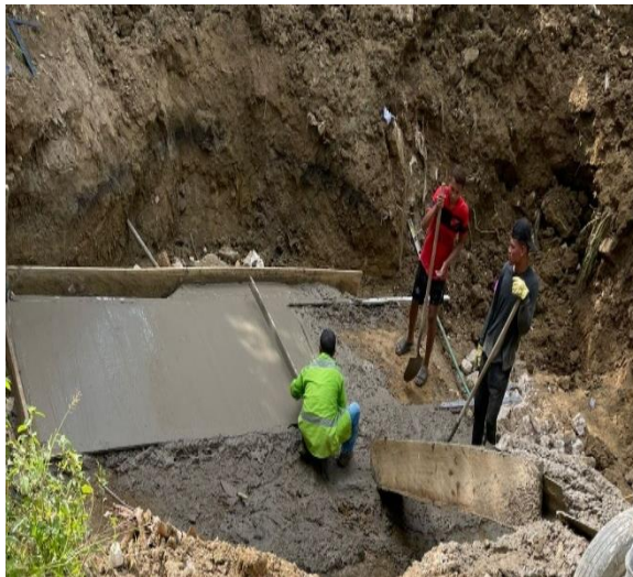
ÍTEM No. 15: CONCRETO DE RESISTENCIA 14 Mpa (TIPO F) (PARA SOLADO Y E = 5 CM)
