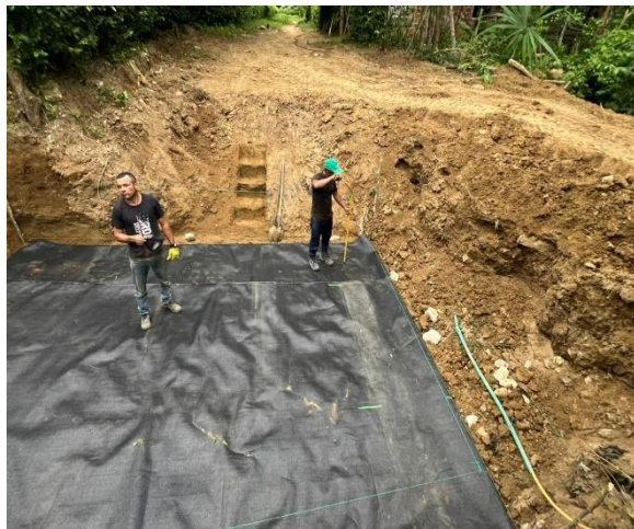
ÍTEM No. 11: MANTO ANTISOCAVACIÓN
