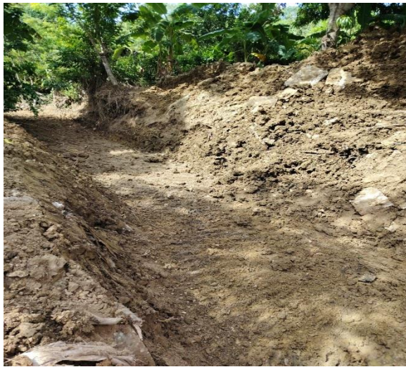
ÍTEM No. 19: EXCAVACIONES VARIAS SIN CLASIFICAR
