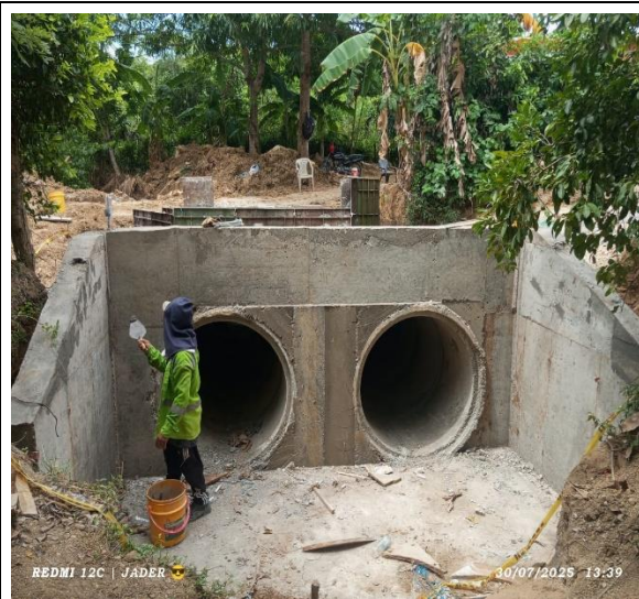
ÍTEM NP -1: CONCRETO DE RESISTENCIA 21 Mpa (TIPO D) (PARA ESTRUCTURA)
