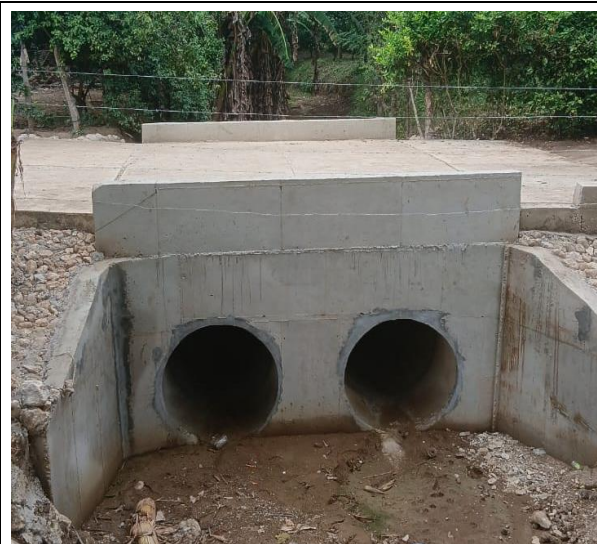
ÍTEM NP -1: CONCRETO DE RESISTENCIA 21 Mpa (TIPO D) (PARA ESTRUCTURA)
