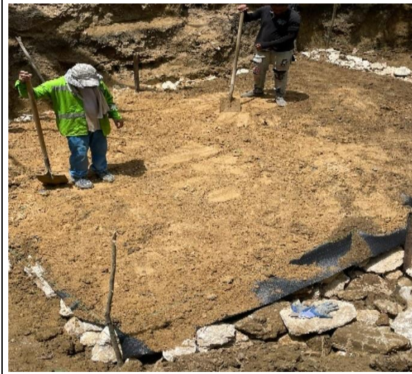
ÍTEM No. 18: RELLENO PARA ESTRUCTURAS (MATERIALES GRANULARES TIPO SUBBASE)
